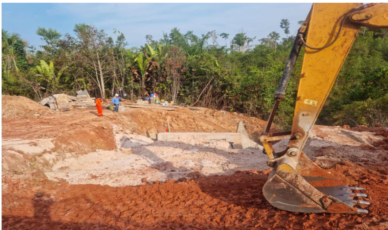
Figura 2 - Registro de obra de instalação de obra de arte no segmento C
